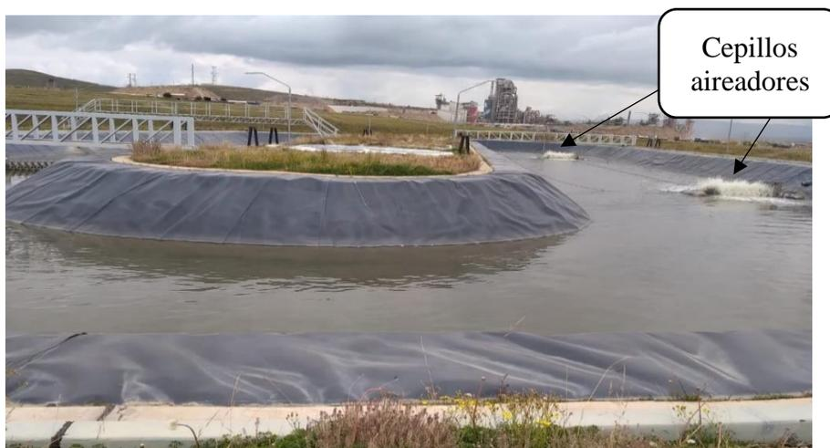
**Figura 16.** Sistema de tratamiento secundario, zanja de oxidación de la PTAR-Viacha.
