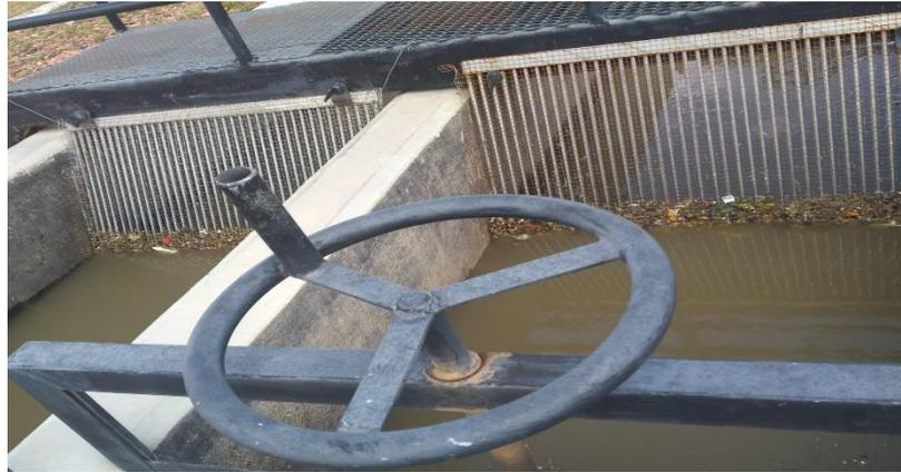
**Figura 14.** Sistemas de pretratamiento (rejillas) de la PTAR-Viacha.
