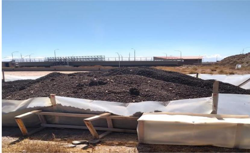
**Figura 20.** Sistema de disposición de lodos PTAR-Viacha.
