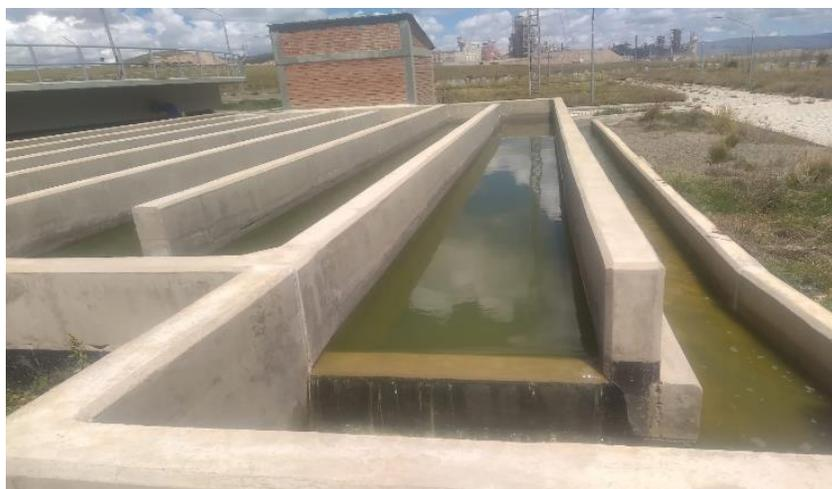
**Figura 18.** Sistema de tratamiento terciario, caseta de desinfección, cámara de contacto y líneas contiguas de direccionamiento de la PTAR-Viacha.
