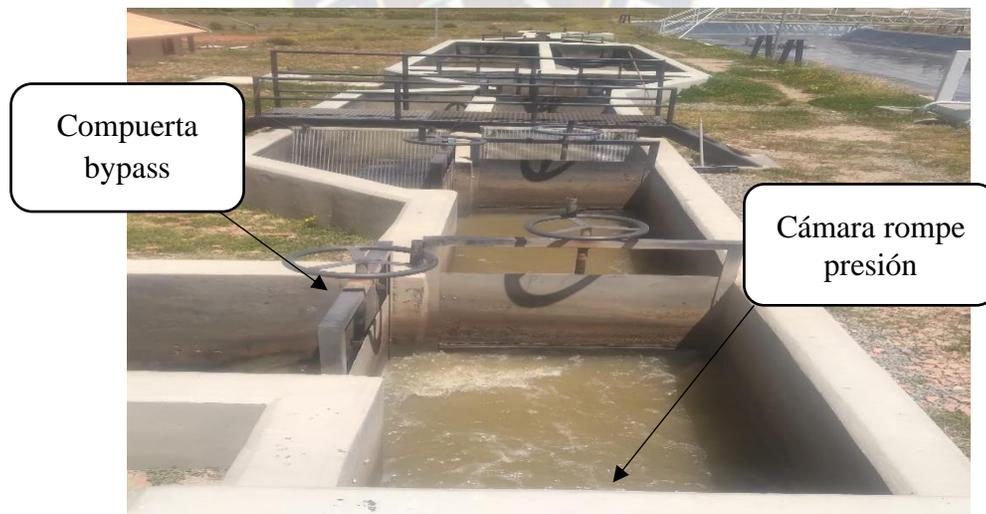
**Figura 13.** Sistemas de pretratamiento cámara rompe presión de la PTAR-Viacha.
