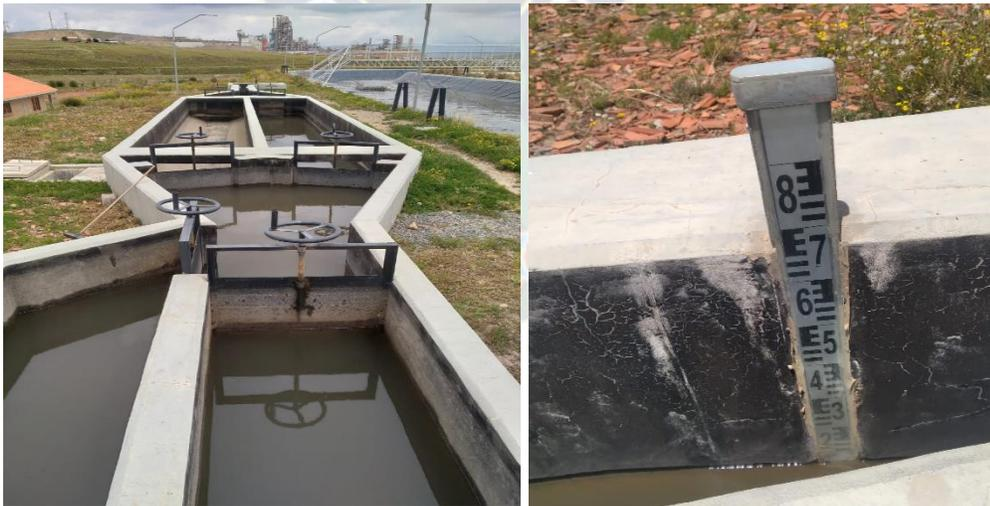
**Figura 15.** Sistemas de pretratamiento canales de desviación, desarenador y el canal Parshall en la PTAR-Viacha.
