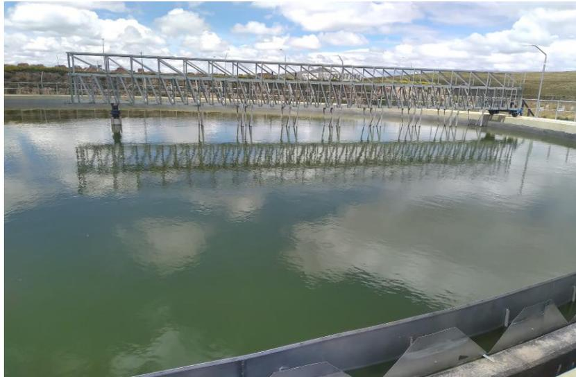
**Figura 17.** Sistema de tratamiento secundario, sedimentador de la PTAR-Viacha.
