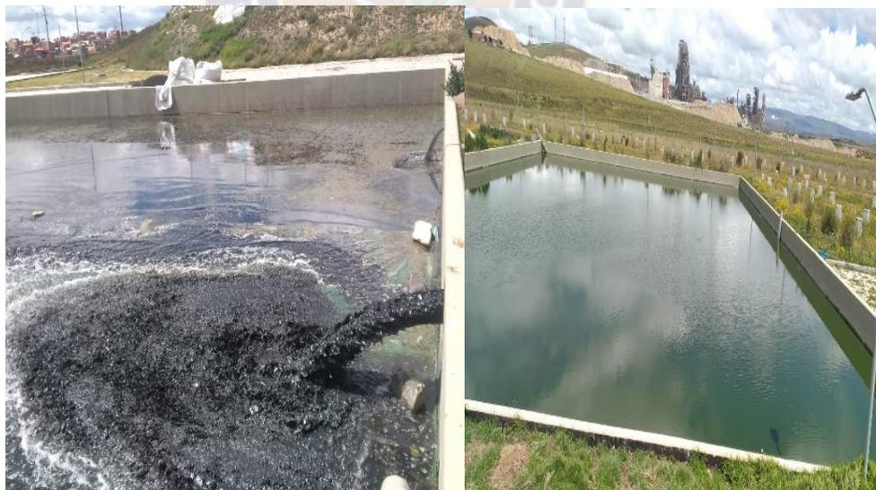
**Figura 19.** Sistema de tratamiento de lodos activados en lechos de secado de la PTAR-Viacha.
