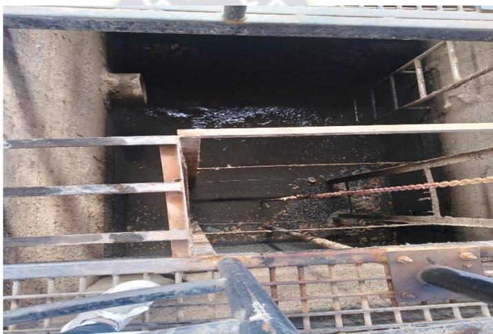
**Figura 11.** Sistema de tratamiento, cárcamo de bombeo de ingreso a la PTAR-Viacha.
