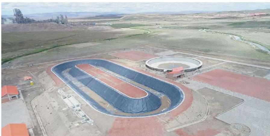
**Figura 2.** Canal de oxidación en la PTAR de Viacha (Bolivia) en construcción gestión (2017-2019)
