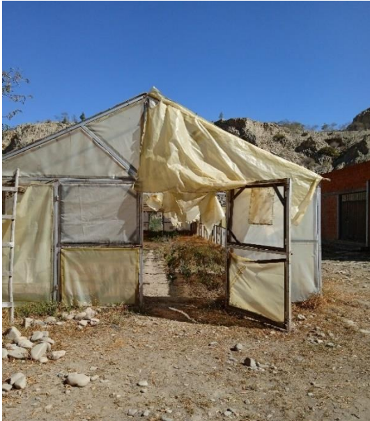
Fotografía 1. Condiciones iniciales de los invernaderos
