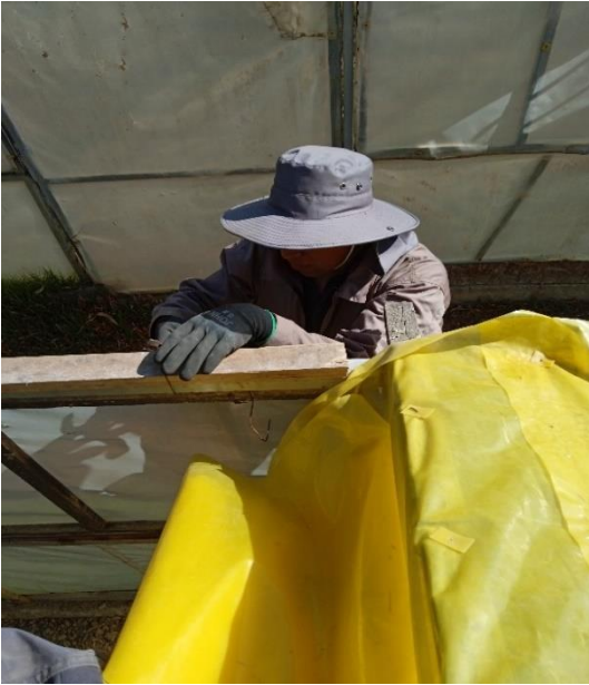
Fotografía 9. Reparación del techo de los invernaderos.
