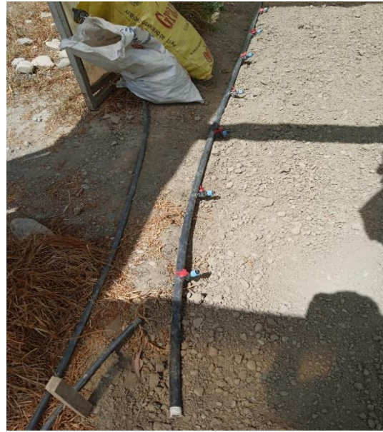
Fotografía 6. Instalación del sistema de riego por goteo
