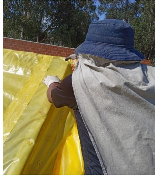
Fotografía 10. Interno de la comunidad ayudando en el techado de los invernaderos
