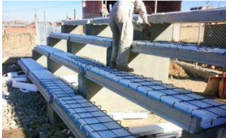
FIGURA 1.6. Gradería de Losas aligeradas con viguetas pretensadas y plastiform
