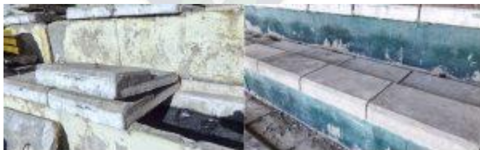
FIGURA 1.7. Gradería de Losas prefabricadas tipo placas de hormigón armado
