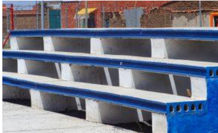
FIGURA 1.8. Gradería de Losas pretensadas huecas
