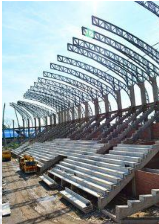
FIGURA 1.9. Gradería de hormigón pretensadas
