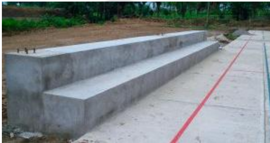
FIGURA 1.5. Gradería de hormigón ciclópeo
