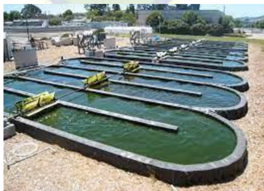
Figura 9 Estanque de canalización
