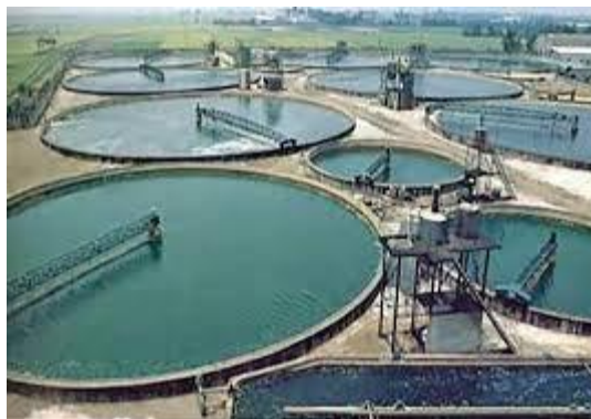
Figura 8 Estanque circular abierto.
