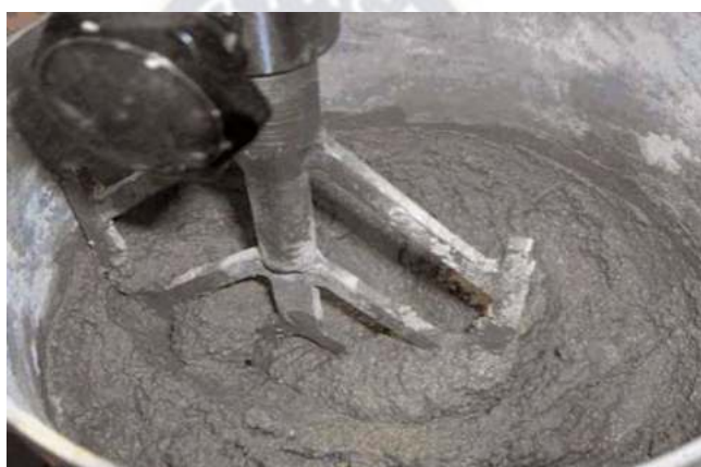
Figura 2.3 Preparación de mortero
