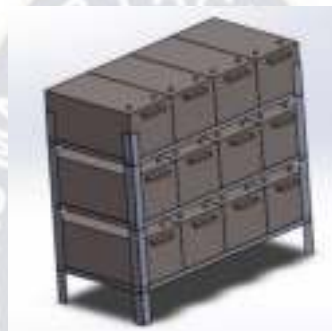
Figura 4.2 Montaje de las baterías en estructura.
