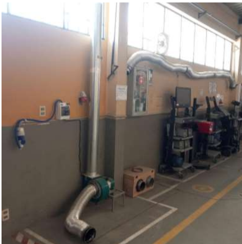
ANEXO 51 IMPLEMENTACIÓN DE UN EQUIPO EXTRACTOR DE GASES (COLABORACIÓN DEL ESTUDIANTE KEVIN MASÍAS PACHECO)
