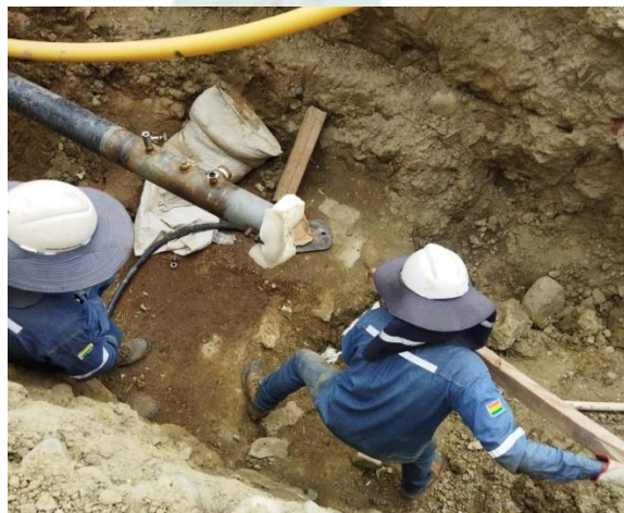
Figura 29. Limpieza interior de la cañería
