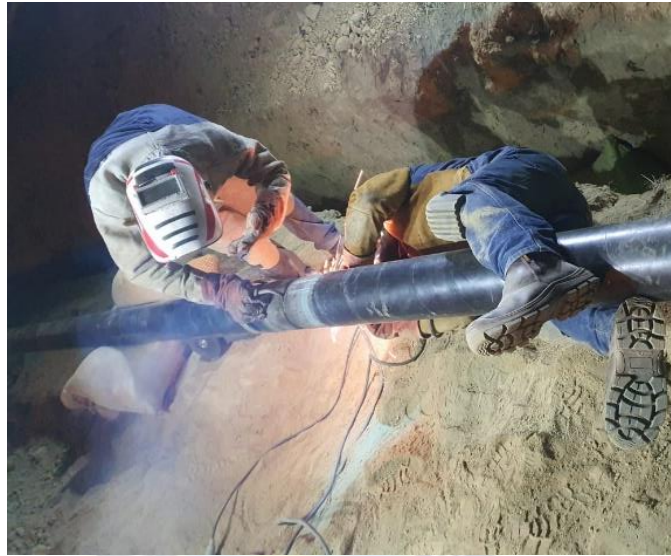
Figura 18. Soldadura de la cañería
