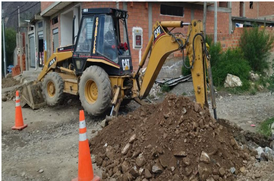
Figura 4. Excavación de zanja
