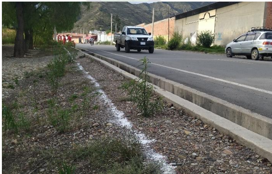
Figura 3. Trazado para excavación de zanja
