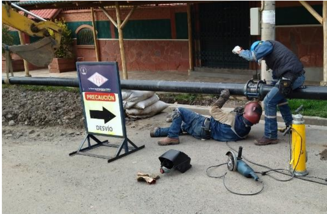
Figura 17. Engrampado de cañerías
