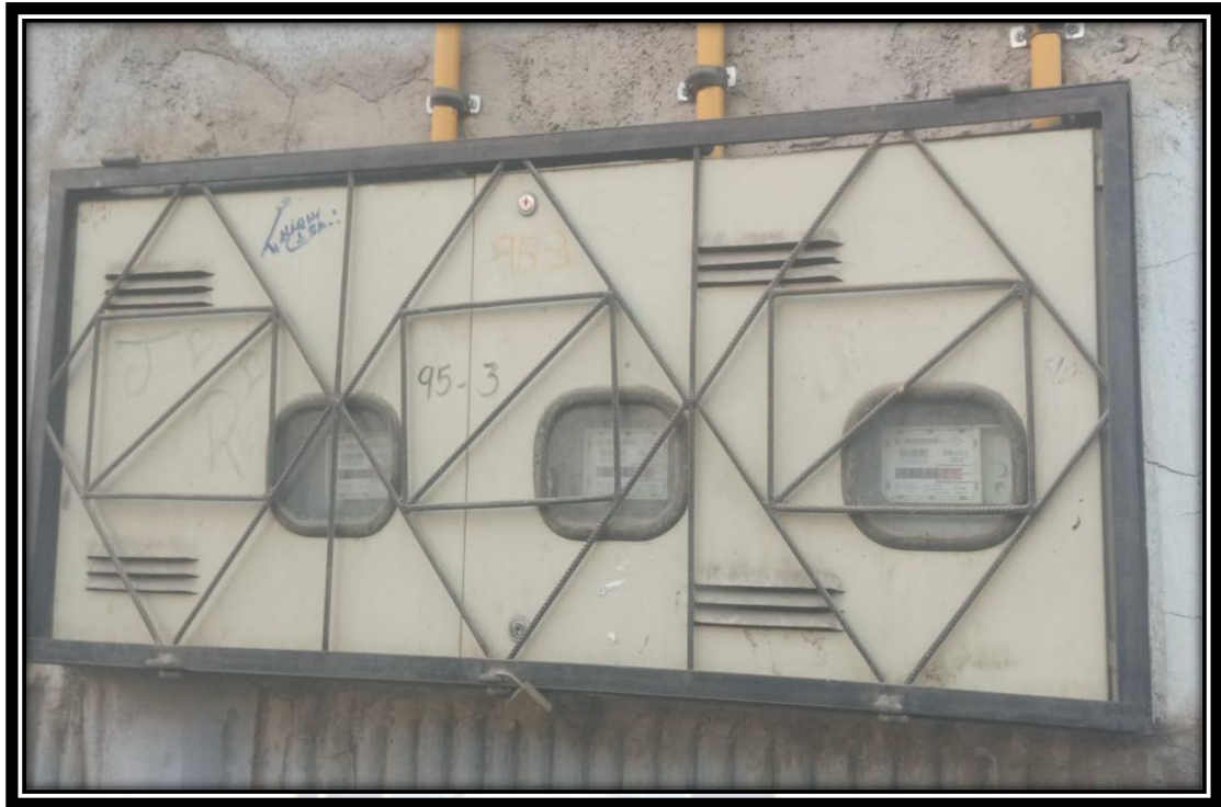
Figura 4. 2 Imagen de medidor de gas domiciliario AB
