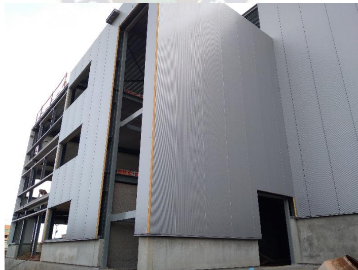
Figura 2. Bloque de administración del almacén logístico INTI
