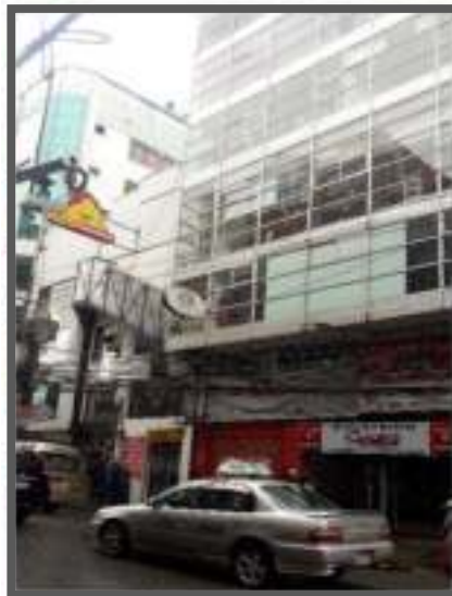
Figura 1.1: Lugar de construcción
