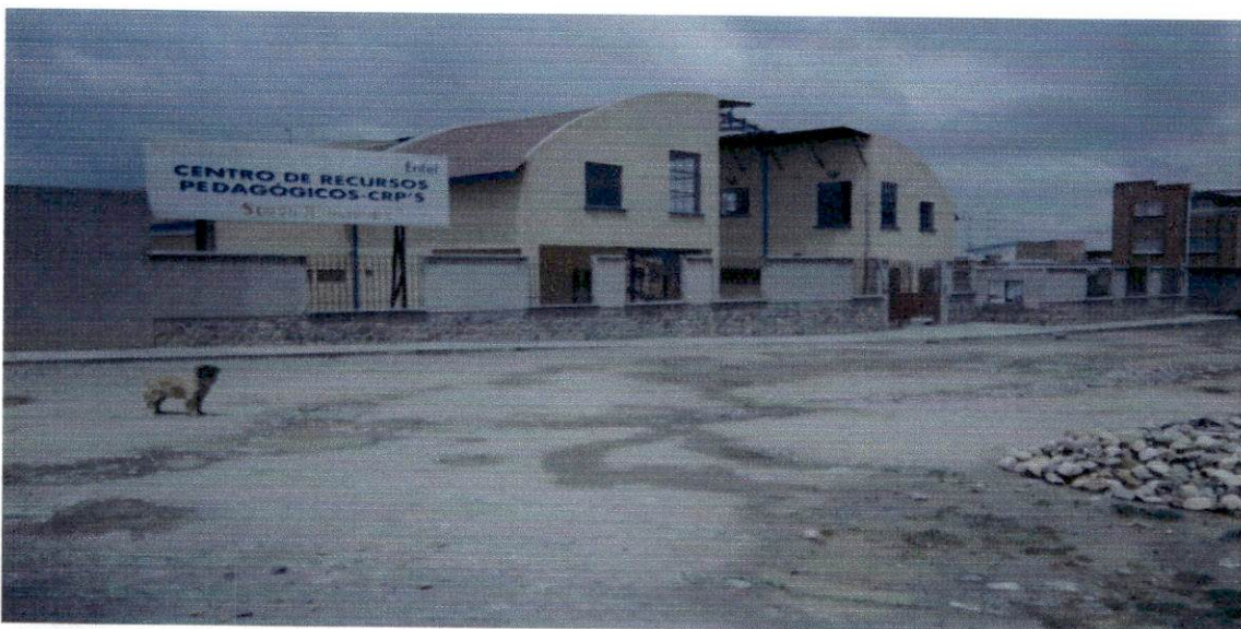
Infraestructura del CRP "Simón Rodríguez"
