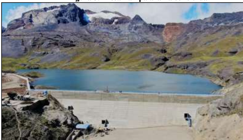
Figura 5. Presa Pampalarama concluida
