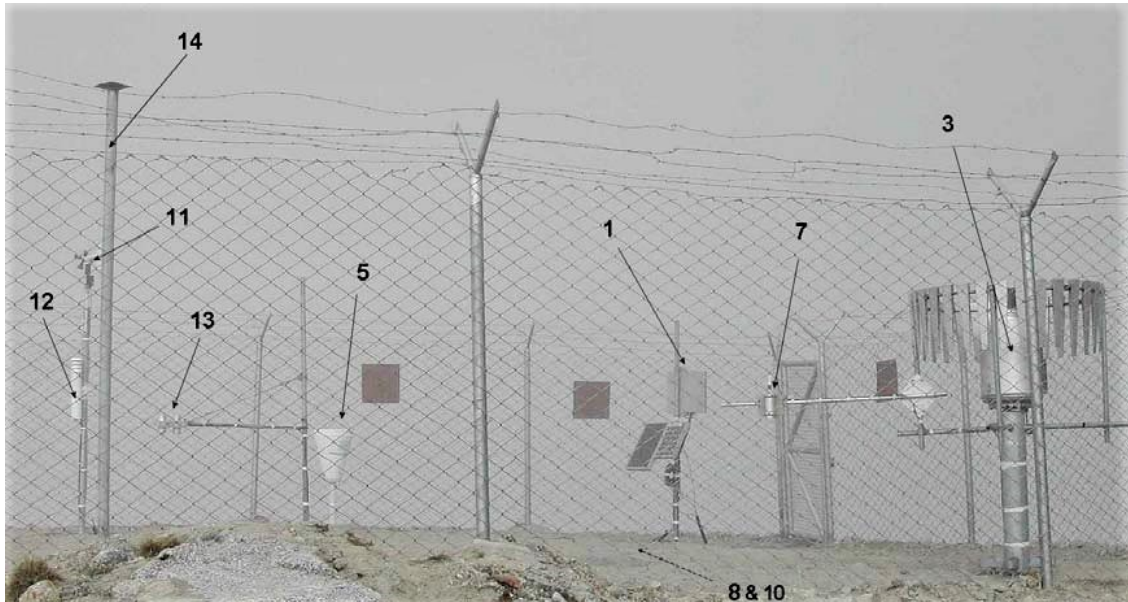
Figura 5.8: Foto de la estación ORE -Zongo (T.Berger), 23/12/2004. Los números de código se refieren a la tabla 5.1, en el código 3 se observa una pantalla corta-viento formada por 32 láminas de metal mantenidas por una estructura circular de 1.20 metros de diámetro. Fuente: Francou et al. (2004a)
