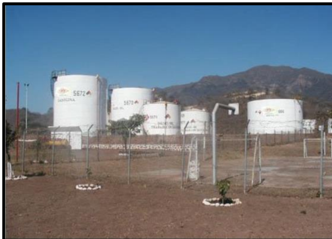
FIGURA 4-5: Estación Terminal Chorety (Camiri)
