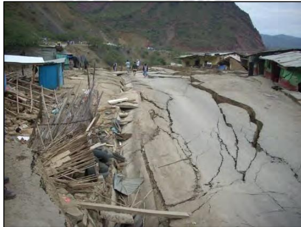
Fuente: Ducto afectado a causa de deslizamiento en Perú, Internet
