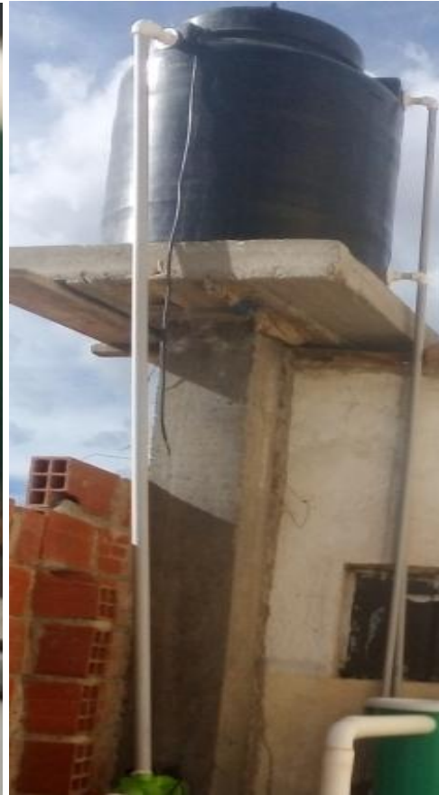
Llenado al tanque de 300 litros
