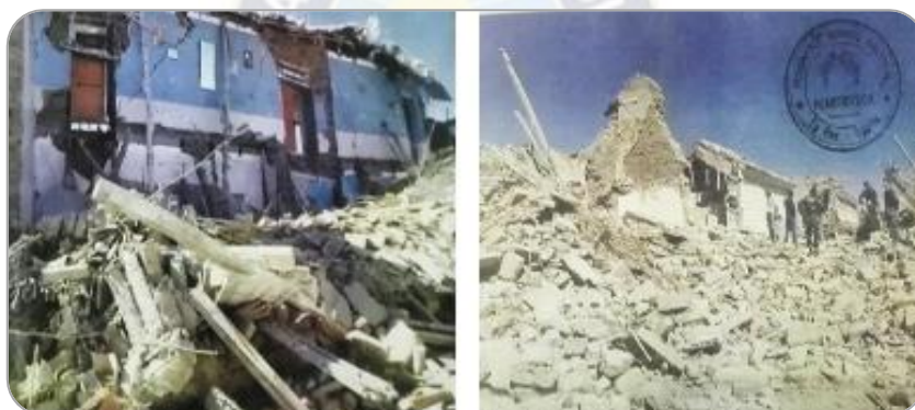
Figura 14. Viviendas de Aiquile destruidas tras el sismo de 1998.
