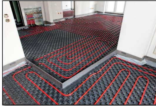
Figura 5.7: Materiales Especiales para Conducción Eficiente en Sistemas de Calefacción por Suelo Radiante.
