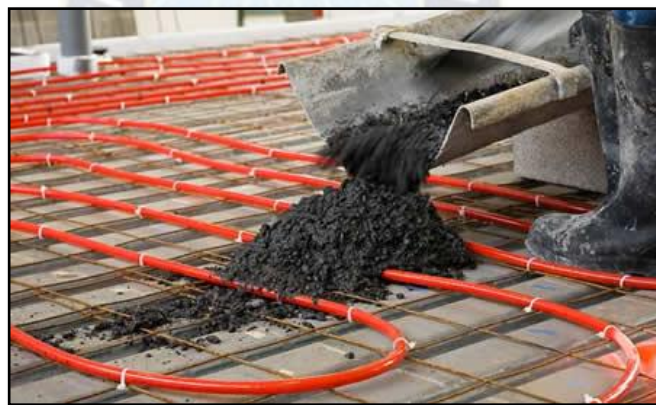
Figura 5.8: Proceso de Aplicación de Mortero para Calefacción: Logrando una Capa Óptima. Fuente: Suelo-radiante.jpg (450×271). (n.d.). https://nergiza.com/wp-content/uploads/suelo-radiante.jpg
