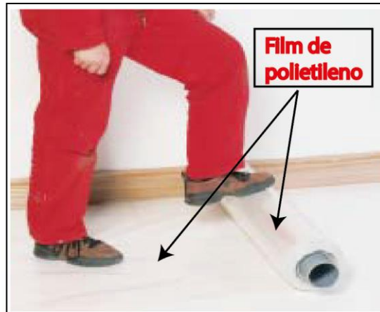
Figura 5.1: Proceso de Instalación de la Lámina de Polietileno y Superposición en las Áreas de Unión.
