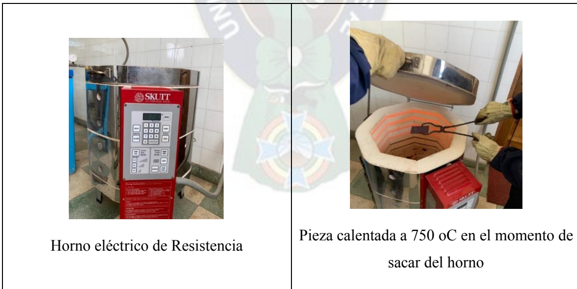
Figura 32.- Horno eléctrico utilizado en el calentamiento de barras de cobre en la laminación.
