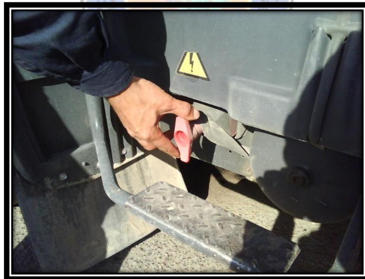
Figura 2. 11 Proceso de anulación de energía
