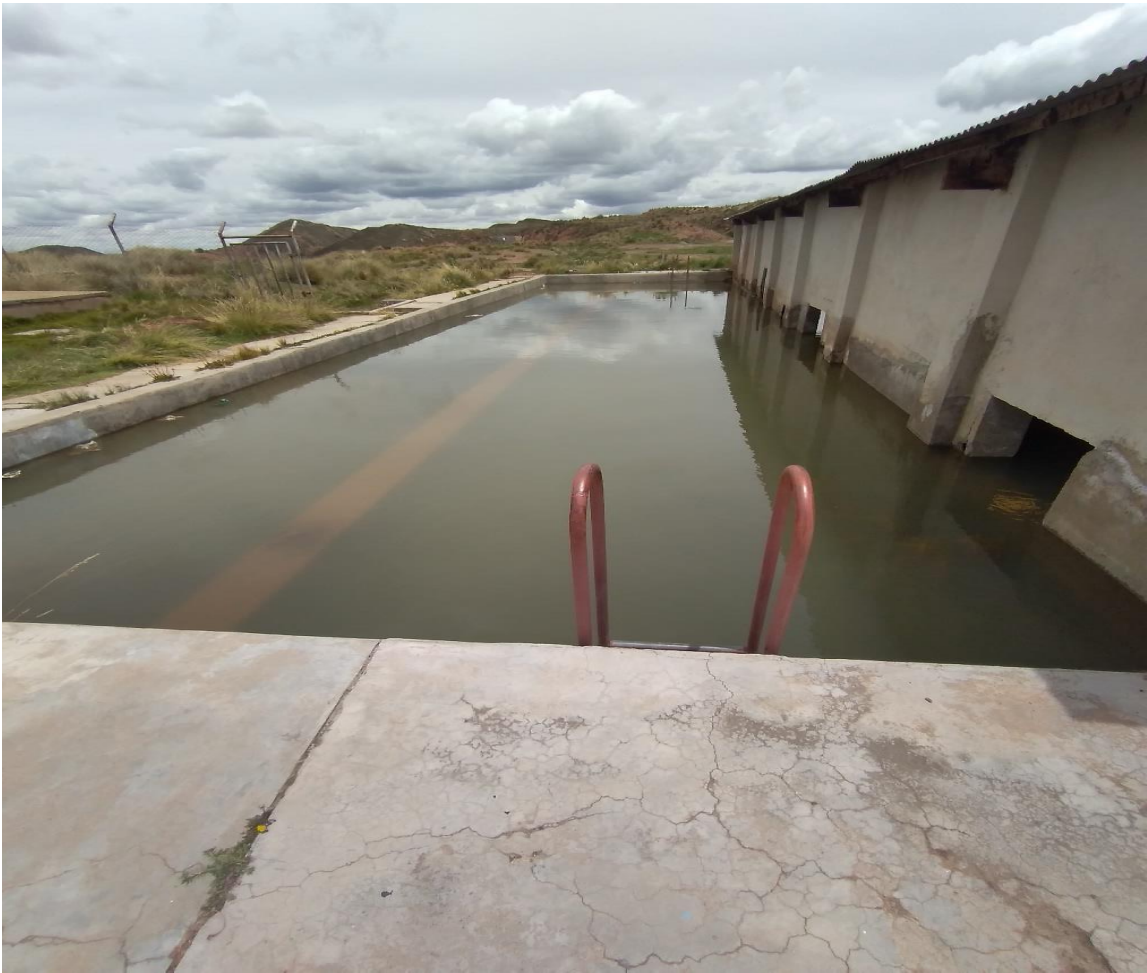
REPRESA DE AGUA DE LA LOCALIDAD DE COROCORO
