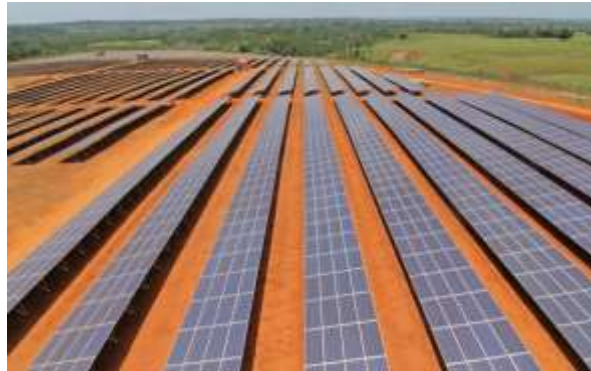
Figura N° 2.1: Instalación de paneles solares en territorio Boliviano
