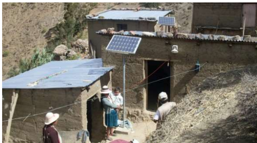
Figura N° 2.3: Instalación de paneles solares en viviendas del territorio Boliviano
