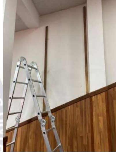
Colocado Listones de Madera
