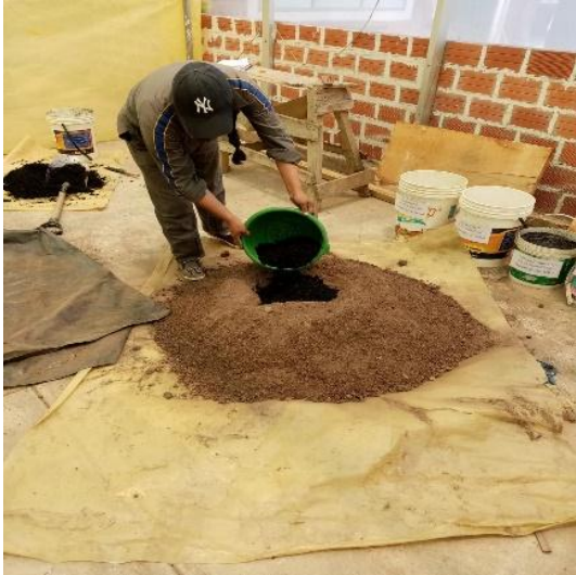
Fotografía 9. Incorporación de la mezcla en el suelo
