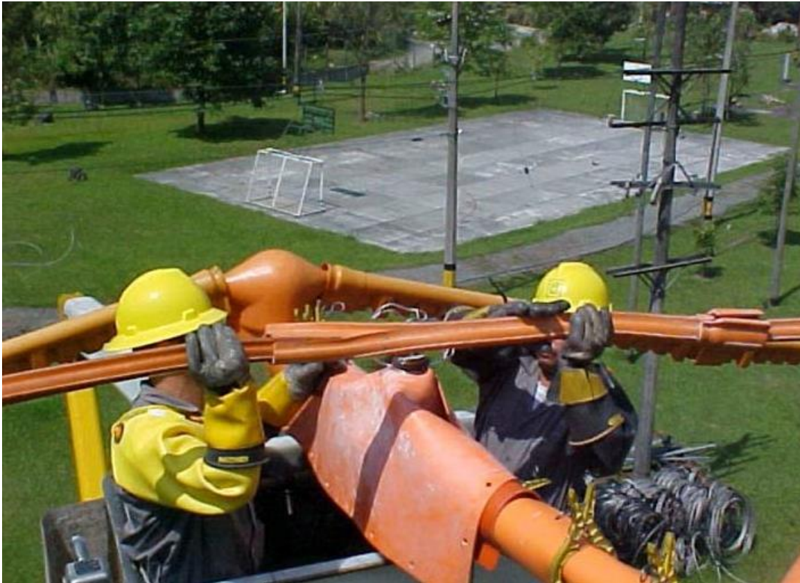
Figura 2. Linieros utilizando la técnica de contacto. FUENTE: CHANCE, Manual para el mantenimiento de líneas vivas.
