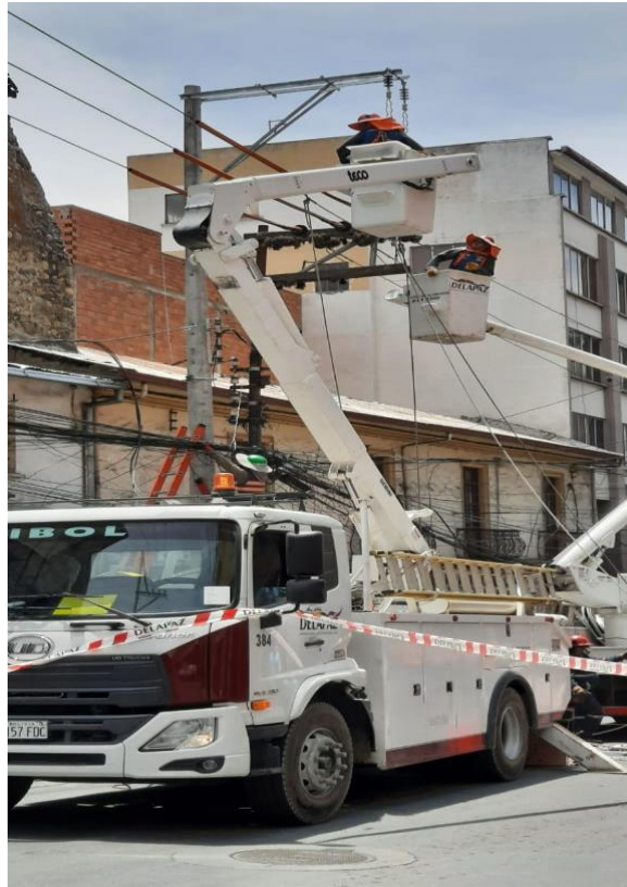
Figura 21, VEHÍCULO TIPO GRÚA CON CANASTA.
