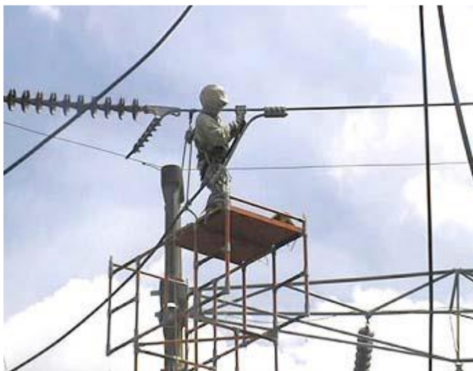
Figura 3. Liniero trabajando con la técnica de potencial.
