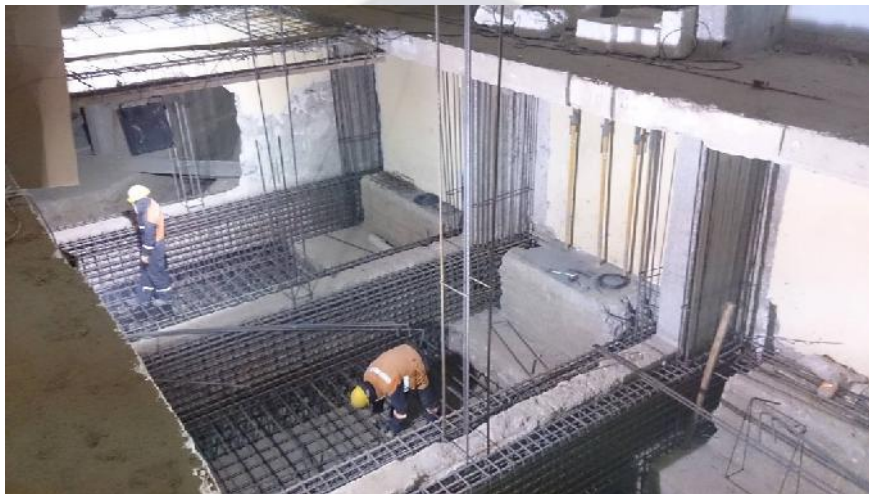
Imagen 22: CONSTRUCCIÓN REFUERZO DE LA CIMENTACION
