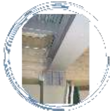
COLUMNA DE H º A º Y VIGA DE ACERO
