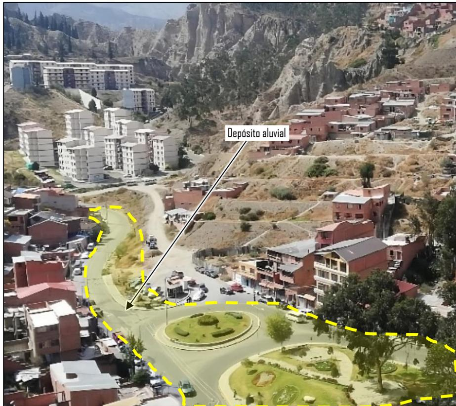
Fotografía 8. Depósito aluvial, actualmente el río Kollpajauira embovedado, cuya función es una vía de comunicación vehicular (elaboración propia).
