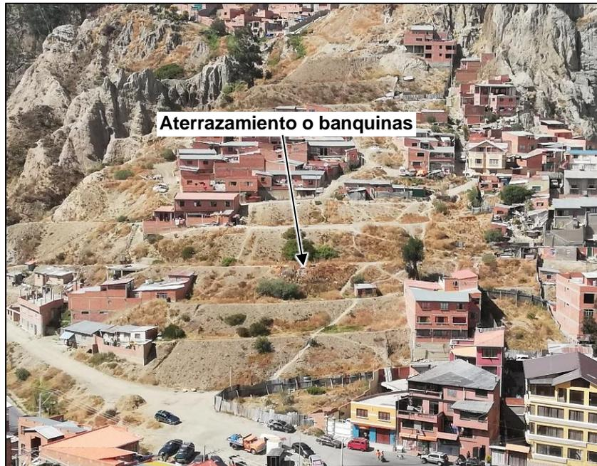
Fotografía 24. Asentamiento de viviendas en las banquinas de estabilización del deslizamiento de Huanu Huanuni (elaboración propia).
