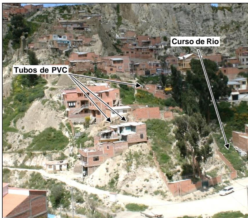
Fotografía 31. Deterioro y mala conexión del sistema de alcantarillado Huanu Huanuni (Guzmán, 2016)
