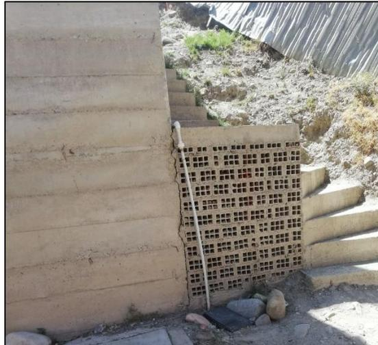
Fotografía 37. Mala conexión de sistemas de drenajes y suministro de agua
