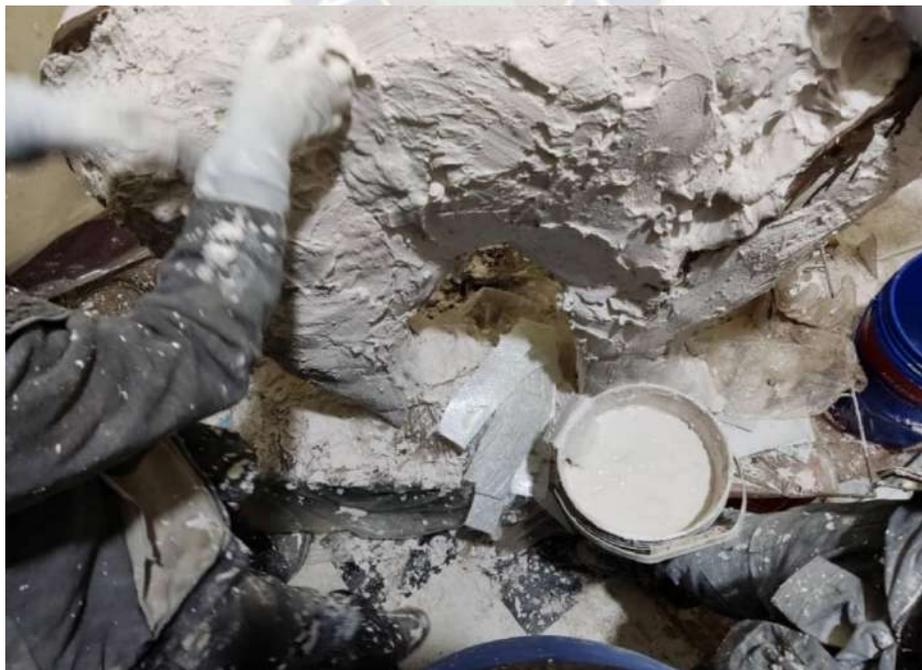
*Ilustración 92. Reforzado de fibra de vidrio en yeso*
