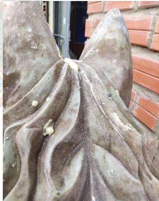
*Ilustración 113. Puntos de fuga de la espuma expansiva B*
