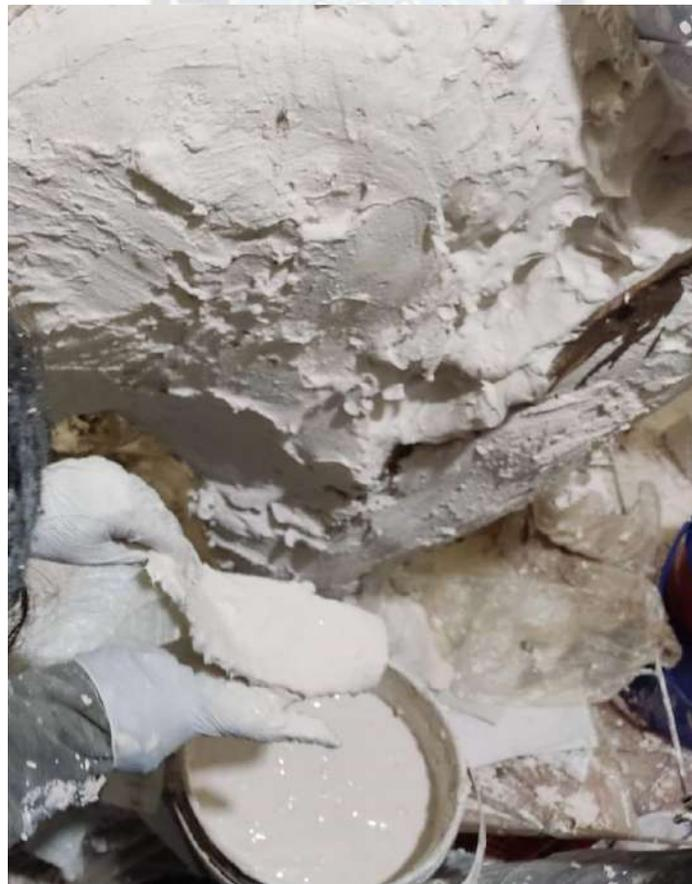
*Ilustración 91. Aplicación de manta de fibra de vidrio con yeso*
