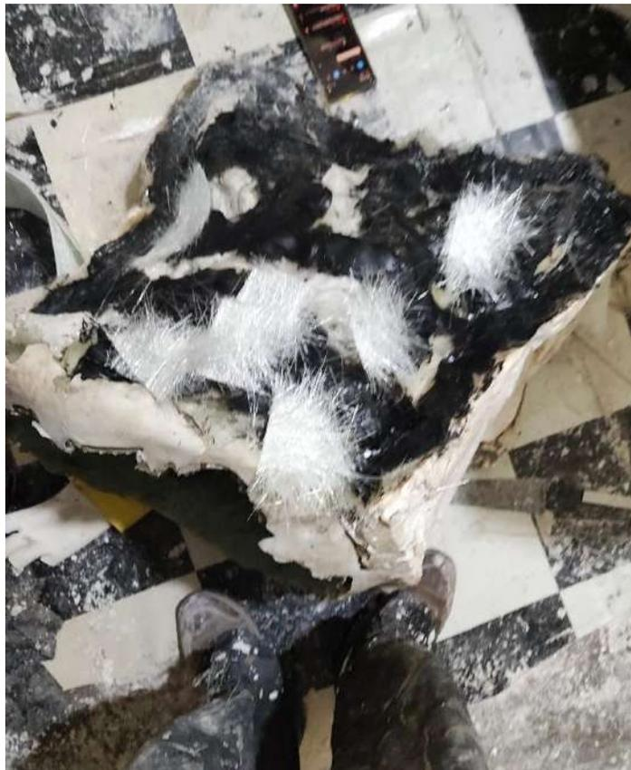
*Ilustración 101. Más aplicación de fibra de vidrio sobre resina*
