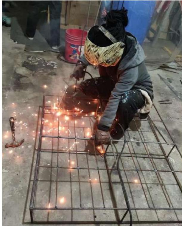
*Ilustración 31. Soldadura y armado de soportes metálicos*
