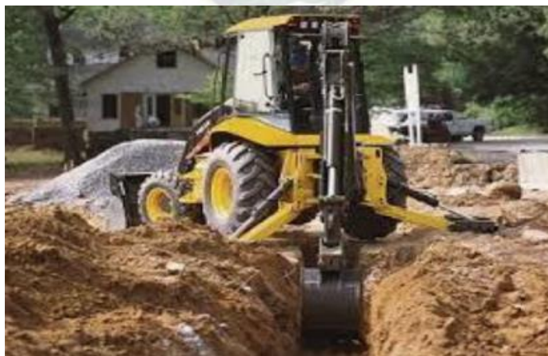
Figura 11. Zanjas con Maquinaria para el Tendido de Redes de GN
