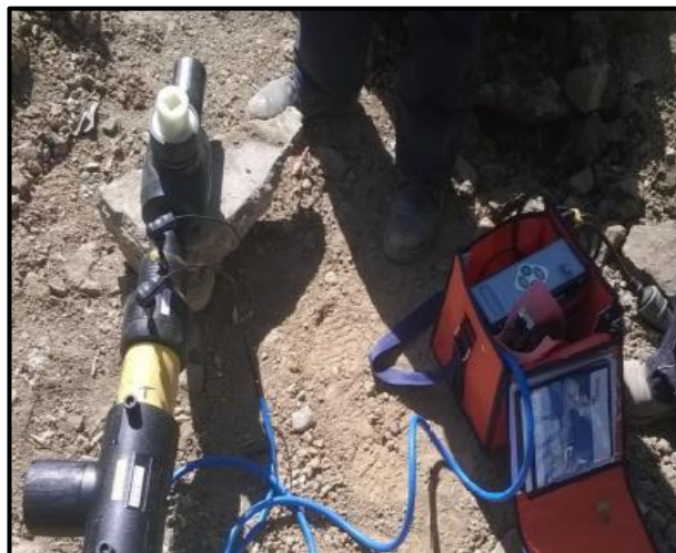
Figura 15. Unión de Tuberías de Polietileno, Mediante Electrofusión
