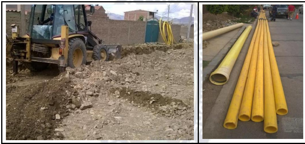
Figura 13. Desfile de las Tuberías de Polietileno
