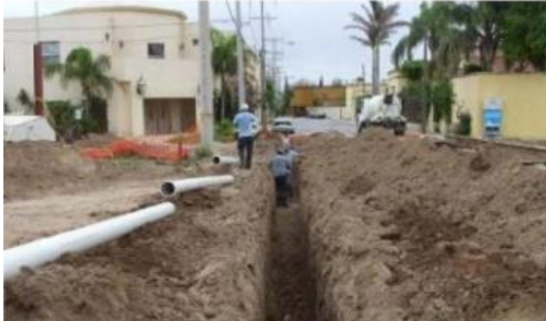
Figura 10. Zanjas Manuales para el Tendido de Redes de GN
