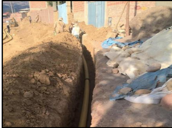
Figura 14. Obreros Realizando la bajada de las Tuberías de Polietileno
