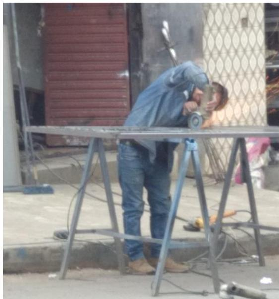
Imagen Nª 2. El operador no usa equipo de protección y se ve los cables en exposición en la vía publica
