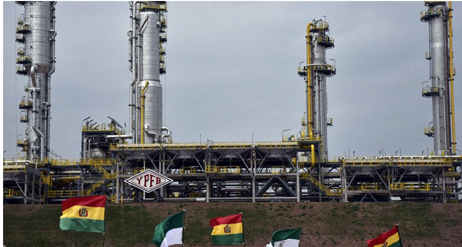
Figura N° 2.15: Planta Separadora de Líquidos Carlos Villegas
