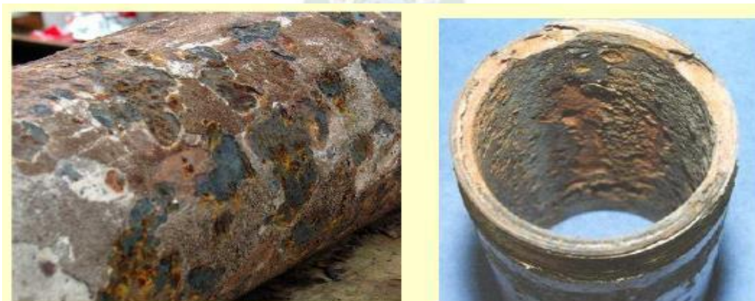
Figura 2.1. Pitting por la presencia de H_2S
