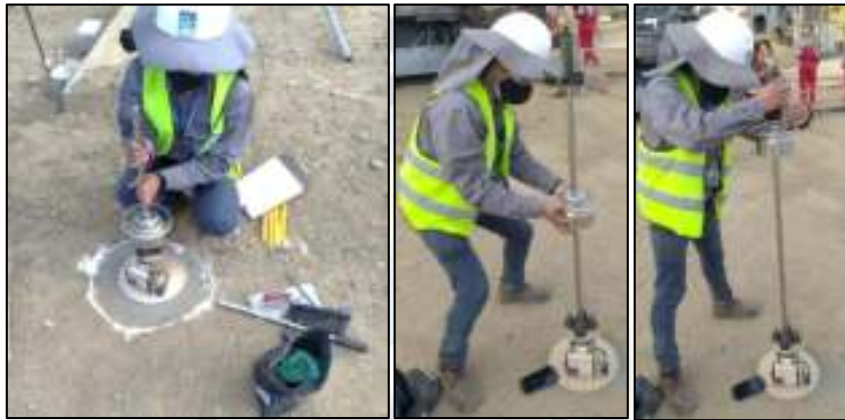
Figura 71. Ensayo en campo Deflectómetro Liviano de Impacto Fuente: Elaboración Propia
