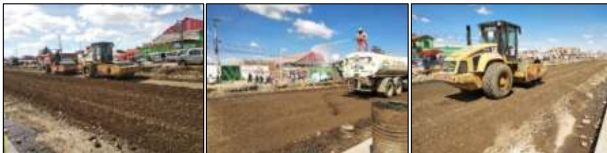
Figura 21. Compactación en campo Fuente: Elaboración Propia
