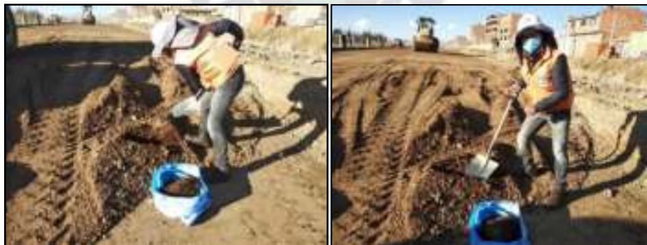
Figura 22. Muestreo de la capa subbase Fuente: Elaboración Propia
