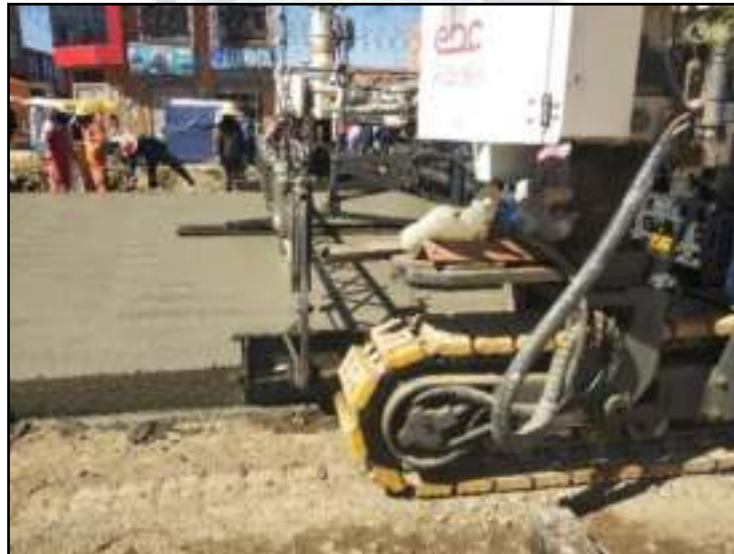
Figura 9. Terminadora Pavimento Rígido, Construcción El Alto - Viacha Fuente: Elaboración Propia
