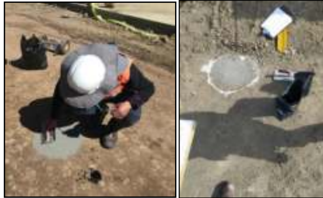
Figura 59. Superficie limpia y nivelada con arena fina Fuente: Elaboración Propia
