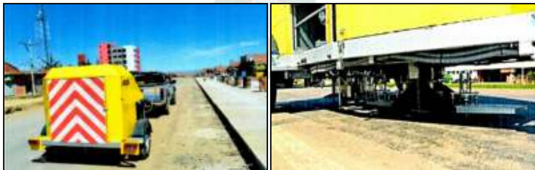
Figura 72. Ensayo de Deflectometría FWD Prog. 11+233 Fuente: Memoria Técnica PR.09.21-01 -Mecanicista Ltda.
