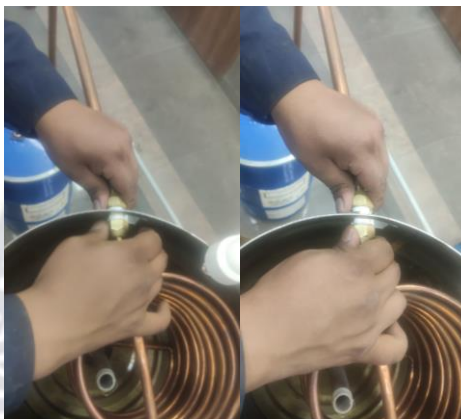
Figura 64 - Instalación de las cañerías de cobre
