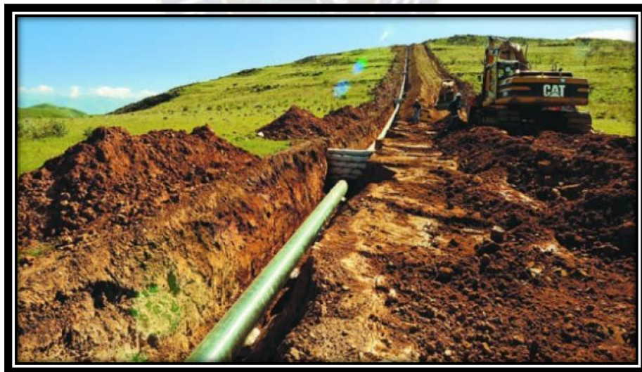
Figura 2. 1: Instalación típica de un gasoducto
