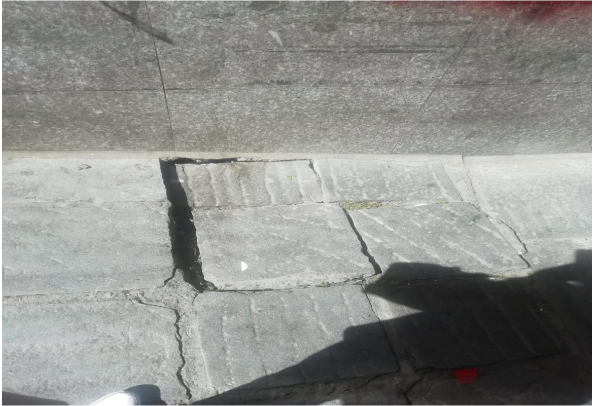
Figura 27. (Calle Ingavi Puerta C.N.S.S.)
