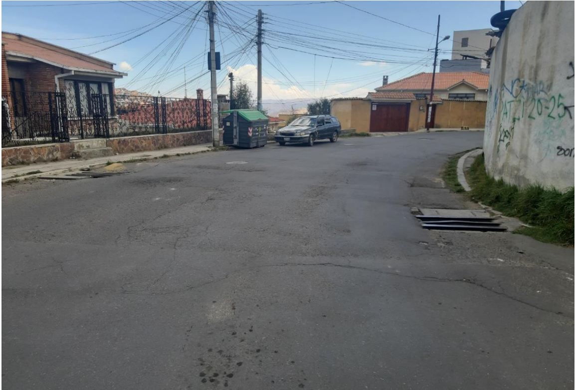
Figura 17. (Calle Guillarte Rompemuelles sin pintar)
