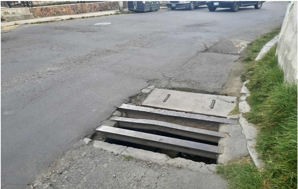
Figura 18. (Calle Guillarte Rompemuelles sin pintar)
