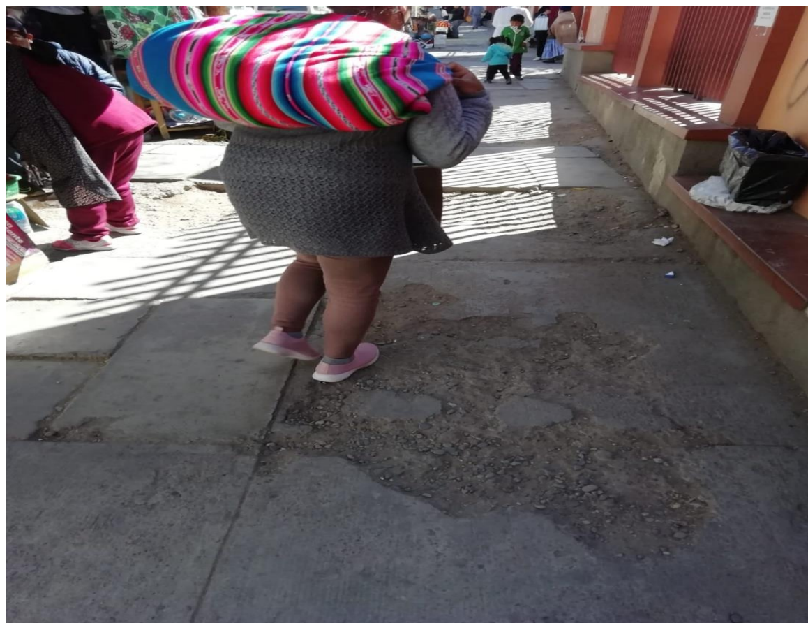
Figura 22. (Avenida Saavedra Hospital de Clínicas)
