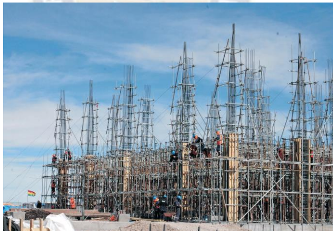
Figura 2.6 Estructura del edificio de la Planta Industrial de sales de Potasio (etapa de construcción). Fuente. Memoria Institucional, Yacimientos de Litio Boliviano YLB. (2019)
