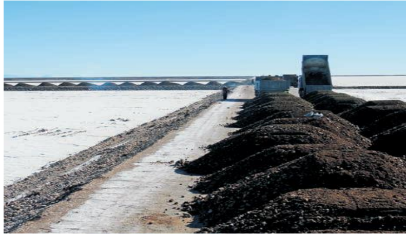
Figura 2.7 Construcción de piscinas industriales.
