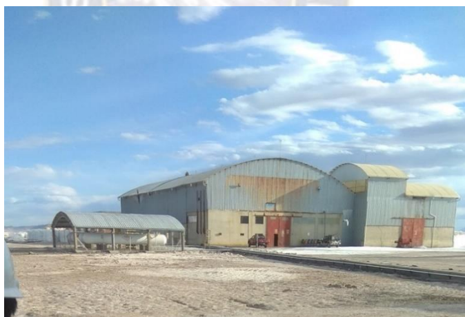
Figura 2.3 Planta Piloto de Cloruro de Potasio.
