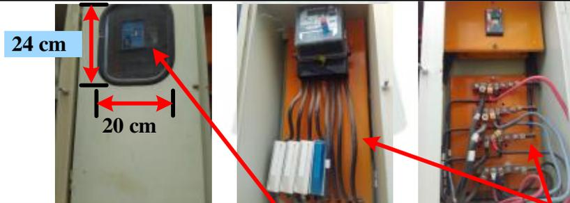
El visor podrá ser de vidrio de 4 mm de espesor o de material plástico policarbonato de 2 mm, ambos de 10 por 10 cm, con garantía de hermeticidad y transparencia
