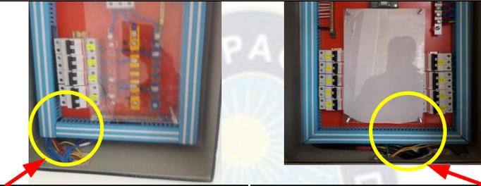
Tablero de distribución empotrada en las paredes del instituto de investigación donde se puede ver la salida de los conductores de los ductos de PVC
