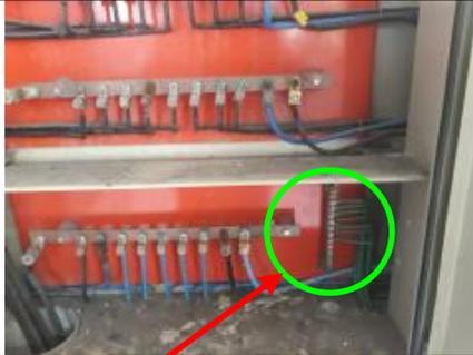
Instalación del tablero de distribución general del instituto con barra de distribución del conductor de tierra
