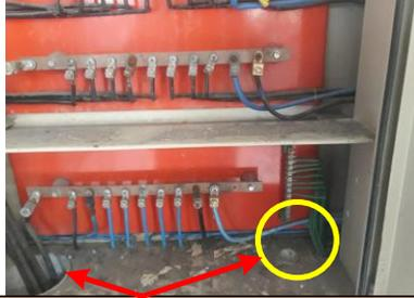
En la fotografía se puede apreciar el ingreso de los alimentadores al tablero de distribución general y la salida de conductores de tierra, a través de ductos
