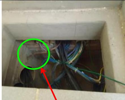
Conductor de tierra desnudo que conecta la malla de tierra y el tablero de distribución general
