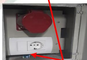
Las fotografías donde se puede apreciar el acceso de conductores a través de ductos de PVC y ordenadas por circuitos como recomienda la norma.
