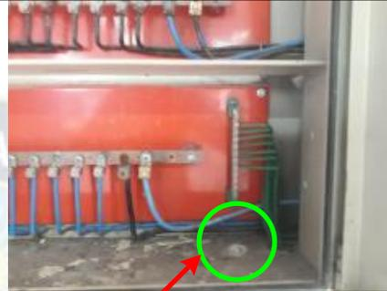
Ducto vacío para conductor de cobre que conecte la malla de puesta a tierra y el tablero de distribución general del instituto
