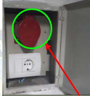
Tablero de protección control de un ambiente, donde se observa el termomagnético S53 ABB de 25C, que protege los circuitos de fuerza trifásicos
