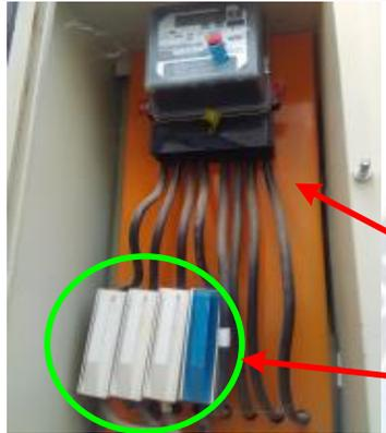
El instituto de investigaciones cuenta con elementos se corte, que son elementos de protección contra cortocircuitos mediante fusibles, instaladas en las fases
