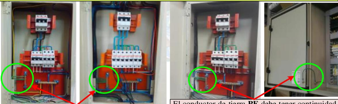
Tablero **TD** de protección y maniobra instalada en los distintos ambientes del instituto con punto para la conexión del conductor de tierra
