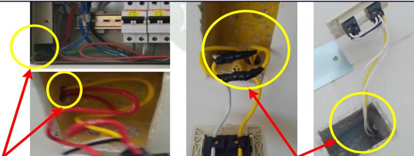
Se puede apreciar el acceso de los conductores a un tablero de distribución y una caja de salida para conexión de placas
