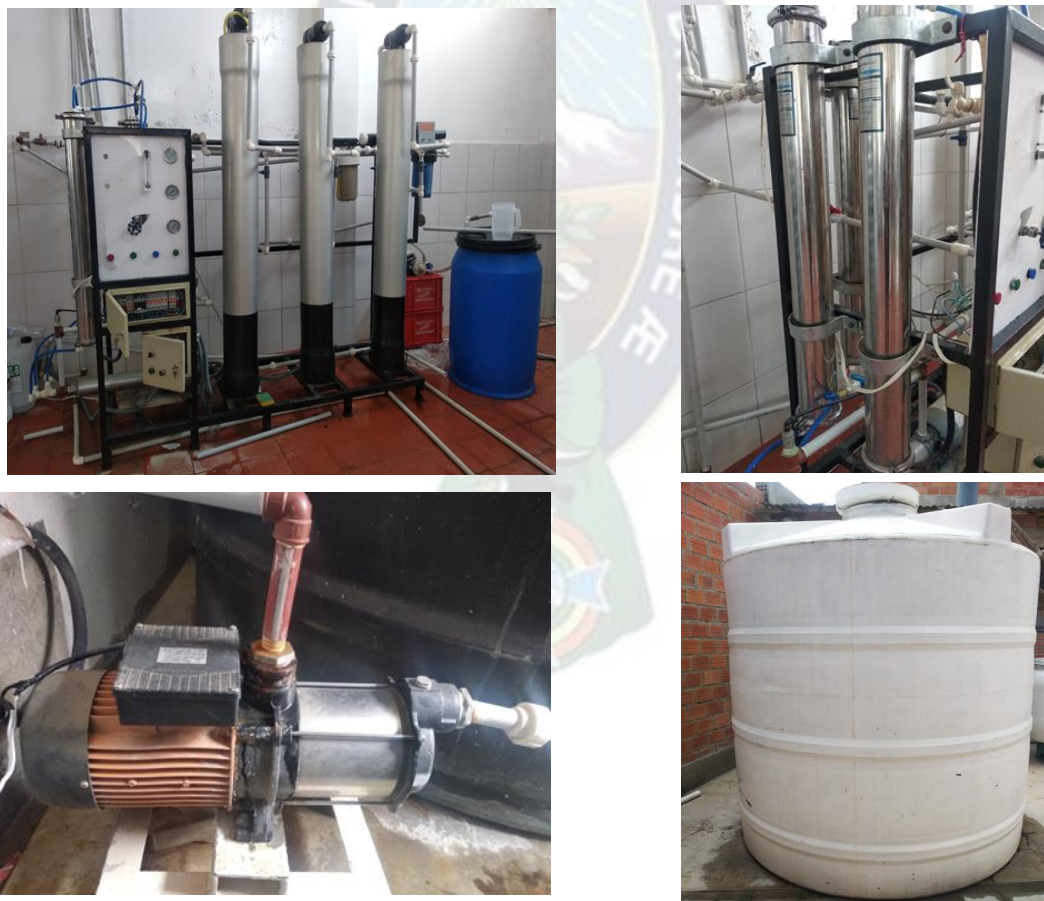
Figura 2.9 Sistema de la osmosis inversa
