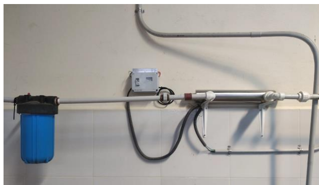
Figura 2.10 Sistema de esterilización con lámpara de rayos u.v.
