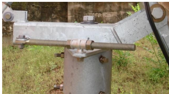
Fig. 29 Tubo de Azimut (Fuente: Material de Visión Mundial, año 2009)
