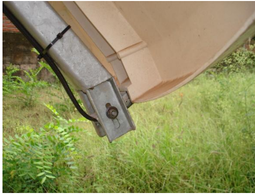
Fig. 40 Tubo y soporte de Feed (Fuente: Vision Mundial, año 2009)
