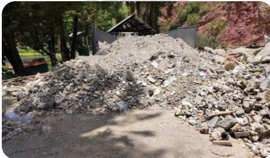
Figura N° 3-1: Residuos de construcción y demolición en la planta de transformación de escombros Fuente: Elaboración propia, 2023
