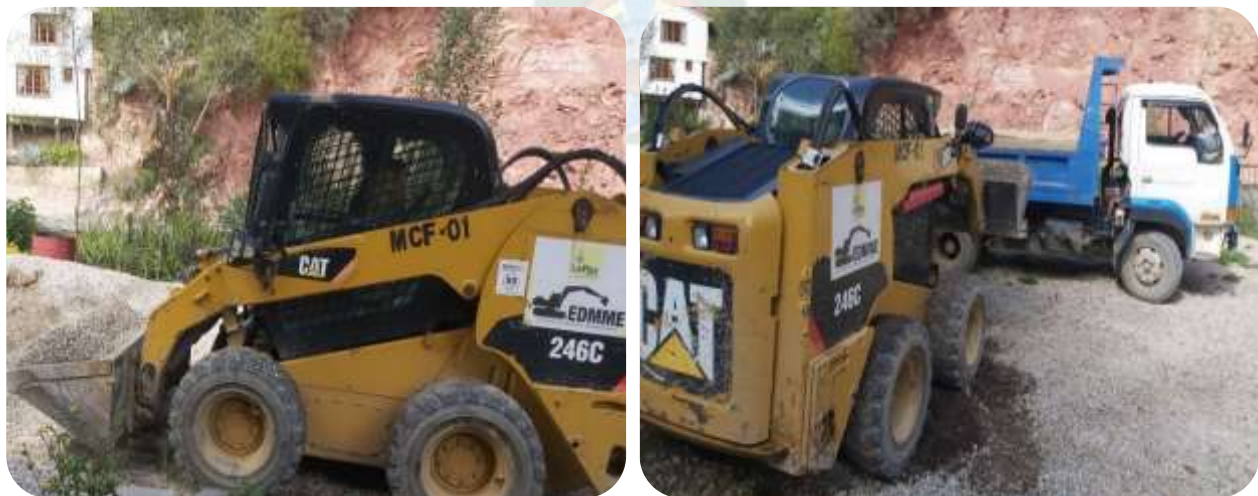
Figura N° 3-6: Traslado de la gravilla reciclada Fuente: Elaboración propia, 2023
