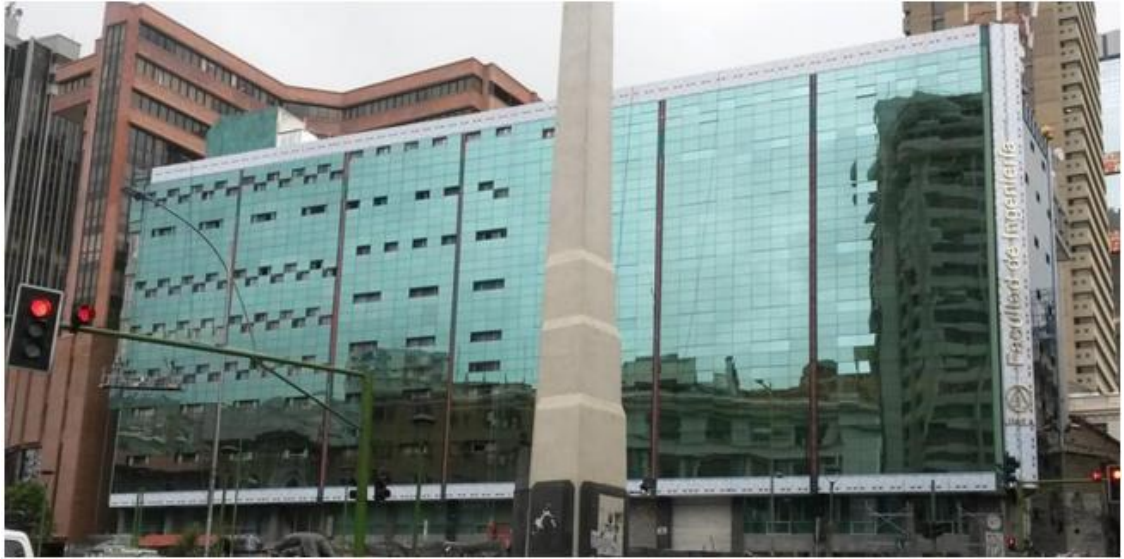
Figura 32: Facultad de Ingeniería, vista frontal
