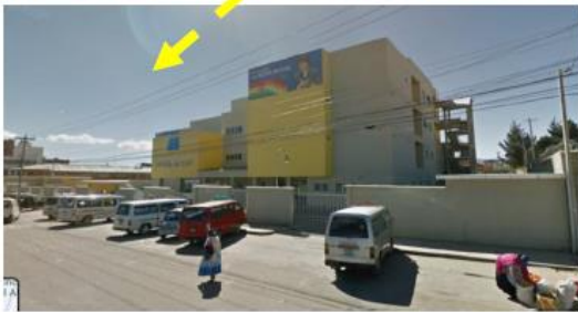
• Fachada frontal del hospital norte El Alto
