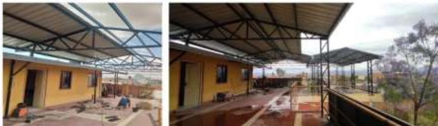
Colocado de cubierta calamina trapezoidal Nº 28 color azul con tornillos autopercutoras traslape de 20cm
