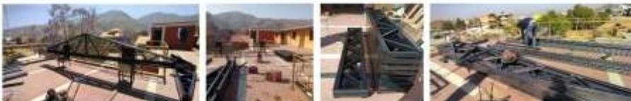
Armado de columnas de estructura metálica (parantes de perfil C 100x50x15x2mm - reticulado de perfil U 70x33x2mm)
