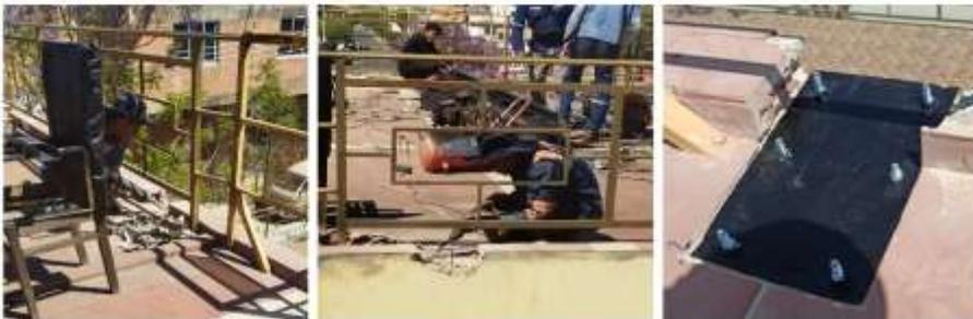
Ranurado de losa para el apoyo de las columnas (herramienta rotomartillo)
