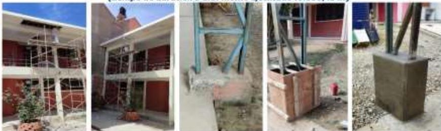
Retiro de revoque de cielo rosa      Revoque de cielo rosa      Recubrimiento de Hª en columnas metálicas - 0,80x0,70x0,40 densificación 10:3
