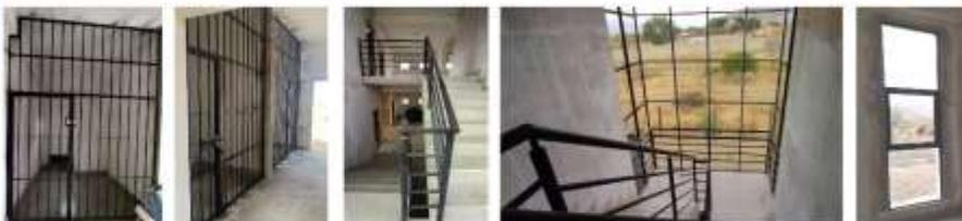
Colocado de rejas metálicas 2m de ancho, 8,15m de alto
