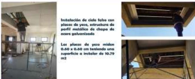
Instalación de cielo falso con placas de yeso, estructura de perfil metálico de chapa de acero galvanizado
