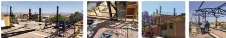
Una vez colocado las planchas metálicas se procede al armado de la estructura 9 columnas con una altura de 2.30 m
