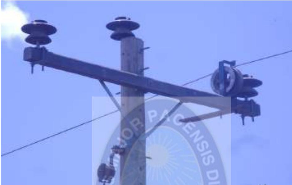
**Foto: Conductor Apoyado Sobre Roldana**
