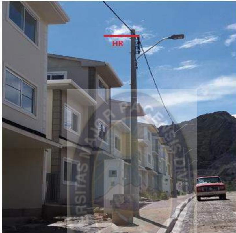
**Foto: distancia de seguridad entre el conductor de BT y la unidad habitacional**
