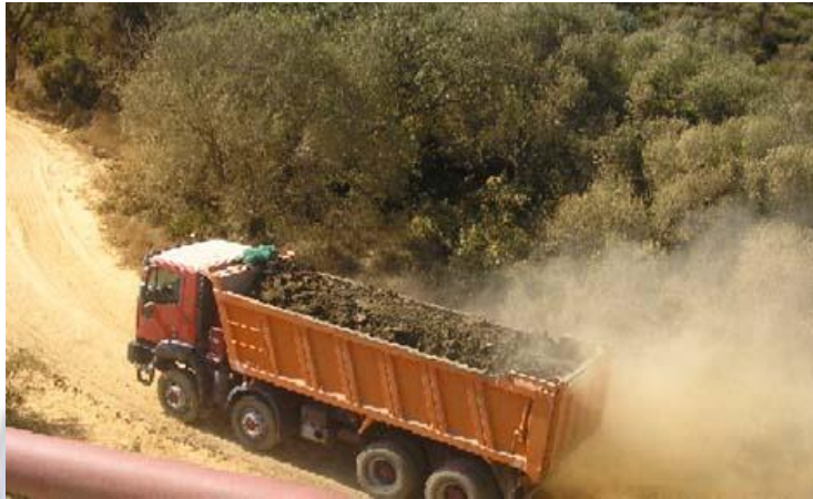
Figura 3.1. Polvo generado durante el movimiento de tierra
