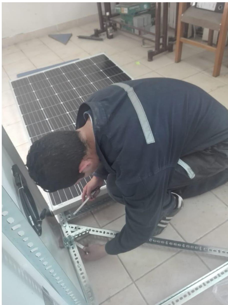
Fotografía 4 Ajuste de módulos a la estructura y verificación previa al montaje
