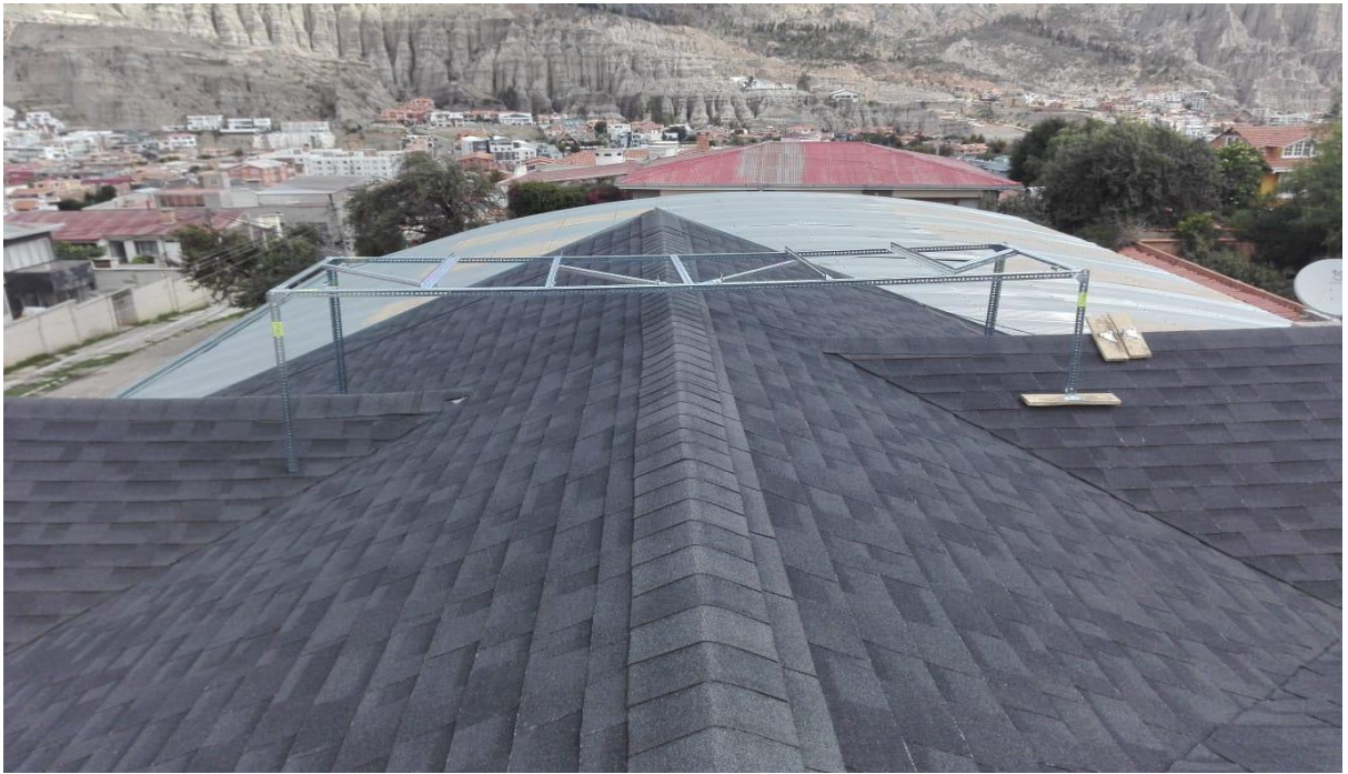
Fotografía 6 Montaje de la estructura en el techo de la vivienda.
