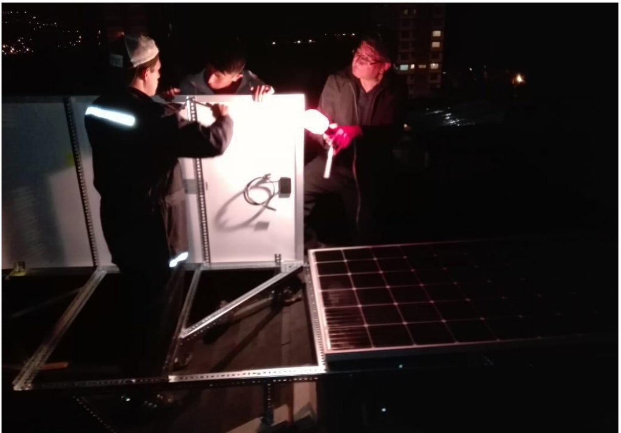
Fotografía 7 Montaje y ajuste de los paneles solares.
