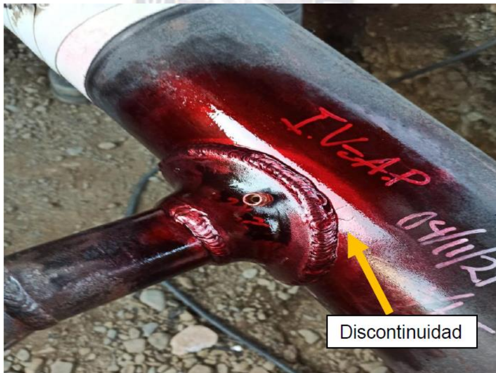
Figura 32. Ensayo de tintas penetrantes a la soldadura
