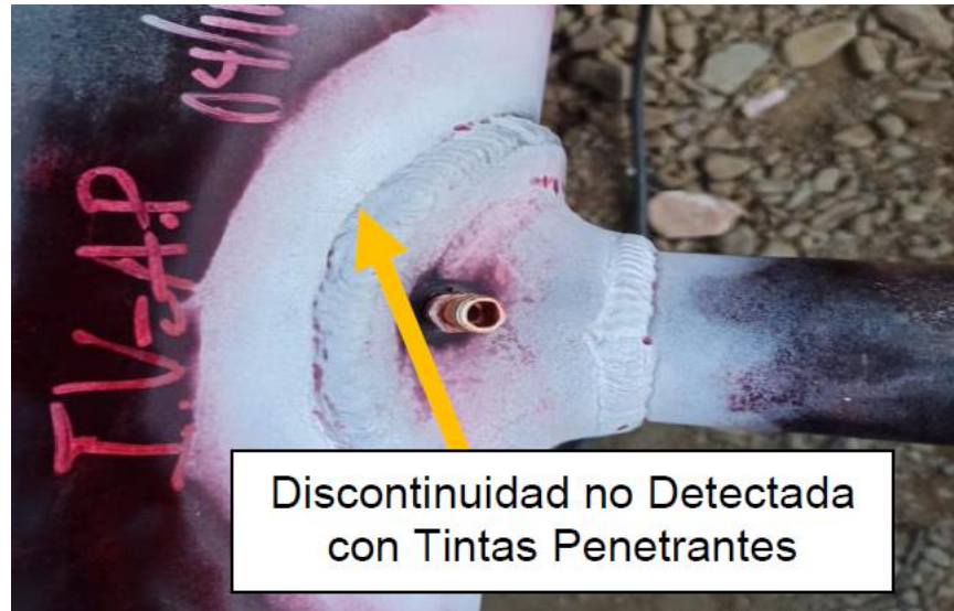
Figura 33. Ensayo de tintas penetrantes a la soldadura
