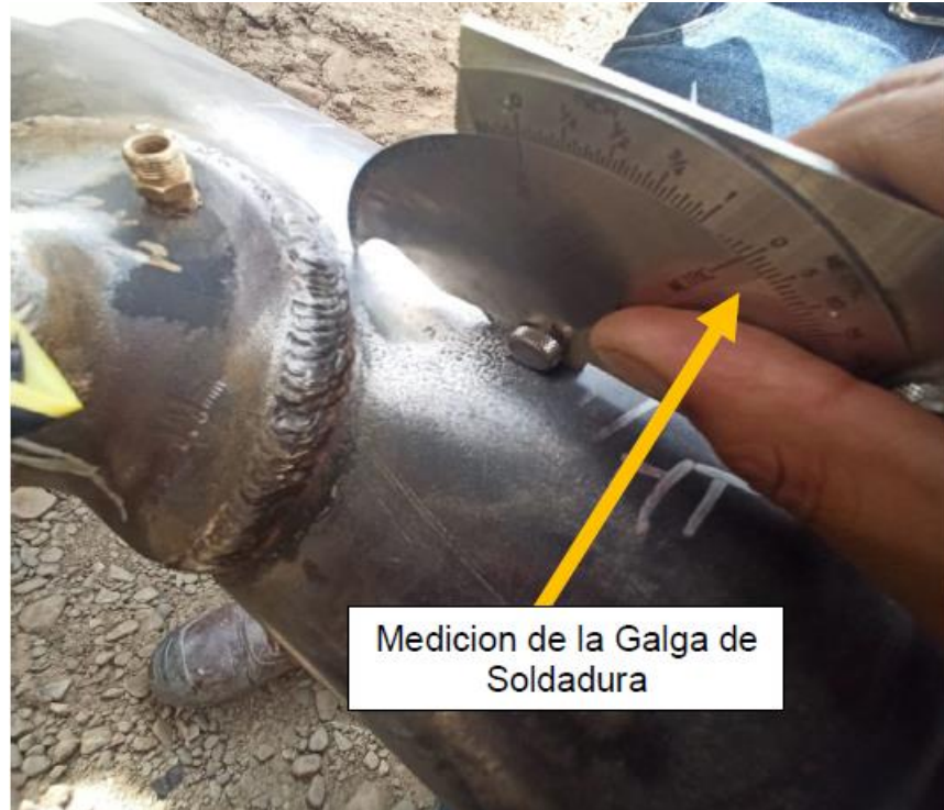
Figura 38. Medición de la profundidad con galga
