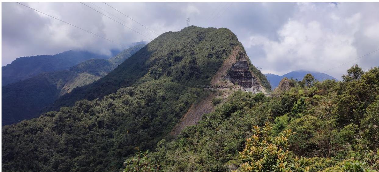
Fotografía N° 8. En primer plano; portal del túnel San Rafael lado Santa Bárbara adicionalmente se observan cimas lineales agudas.
